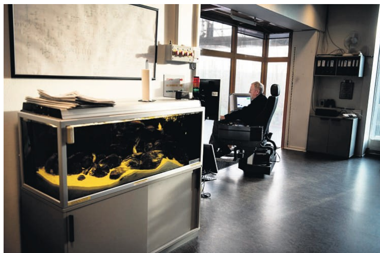
Kraftvarmeværket kan køre fuldautomatisk. Der er sjældent mere end ni på arbejde ad gangen - de fleste i værkstedet og driftsadministrationen. Her ses en af de ansatte i kontrolrummet i færd med at styre affaldskranen.
