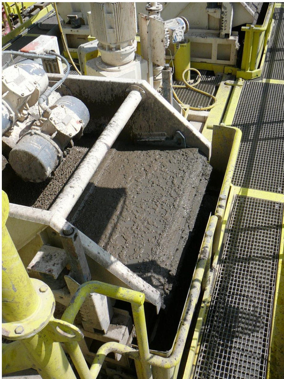
Boreskærverne skilles fra boremuddret – skærverne bortskaffes, mens muddret genbruges
