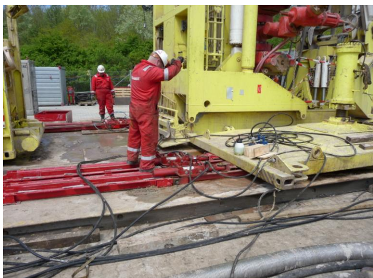
- og det betød, at den 300 tons tunge rig skulle flyttes de 10 meter til toppen af den anden brønd (Foto: Eskild Kristiansen)
