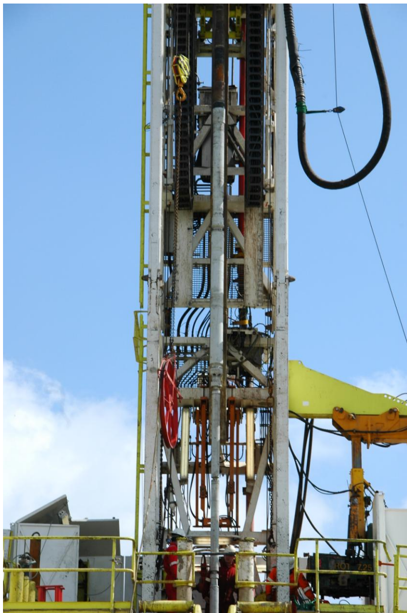
Testpumpen - den lange, hvide tingest midt i boretårnet - på vej ned i brønden (Foto: Steve Devereaux)
