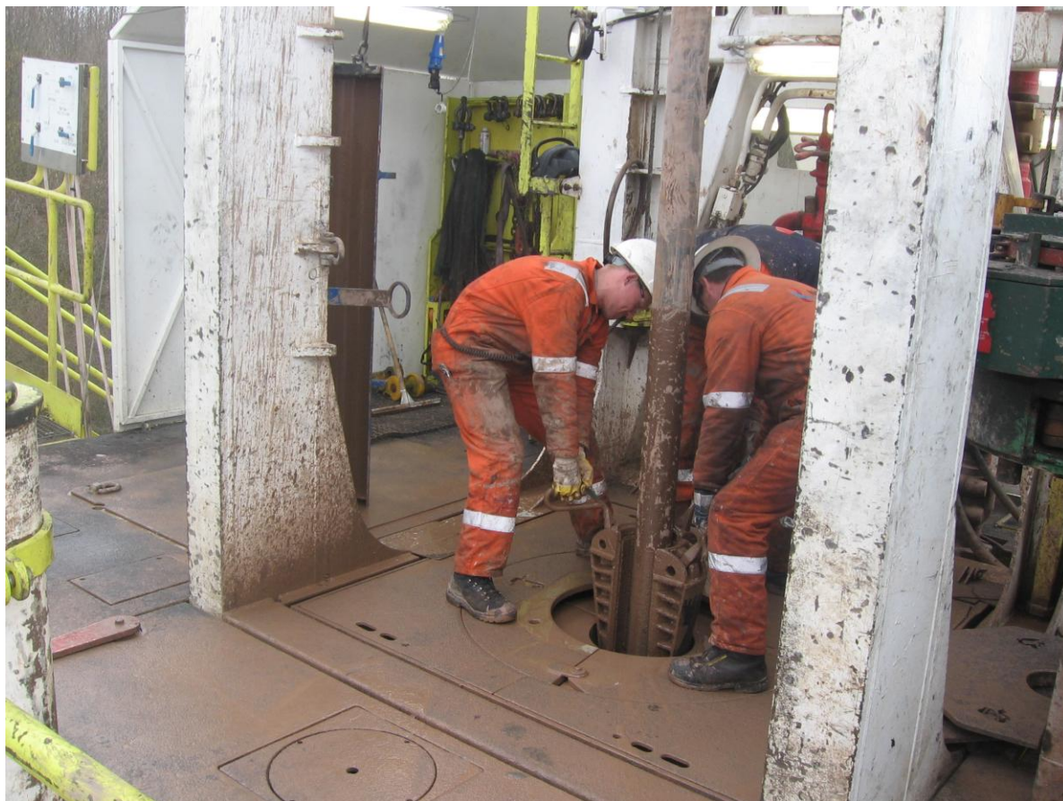
De hollandske borebisser arbejder med at trække borestrengen ud af hullet for at skifte den slidte borekrone
