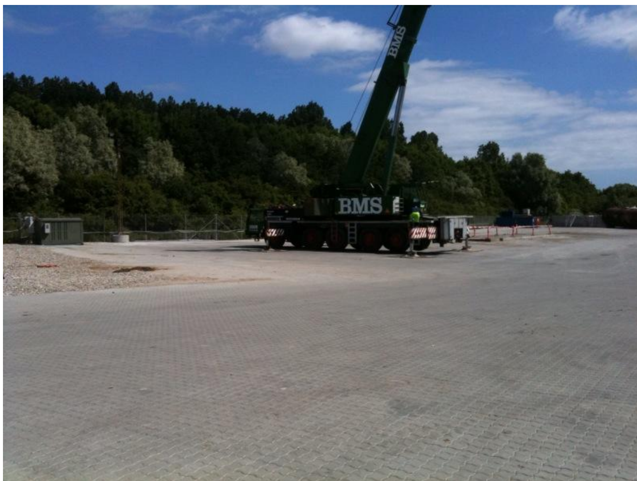
Borepladsen er nu stort set tom – bortset fra en mobilkran, som assisterer med håndtering af testpumpen
